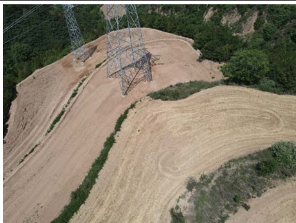
沿线塔基现状
