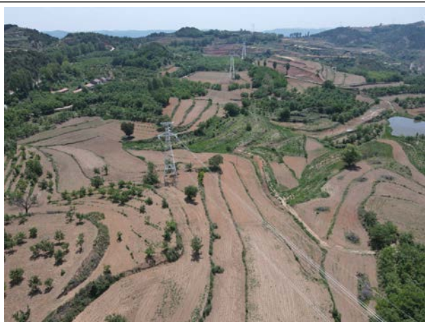
沿线塔基耕地恢复现状
