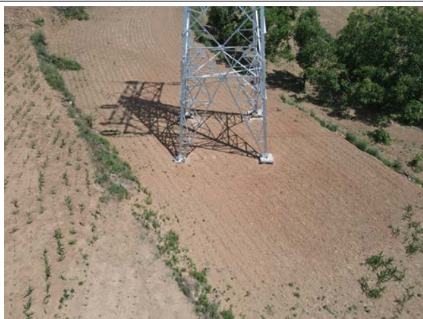
沿线塔基现状
