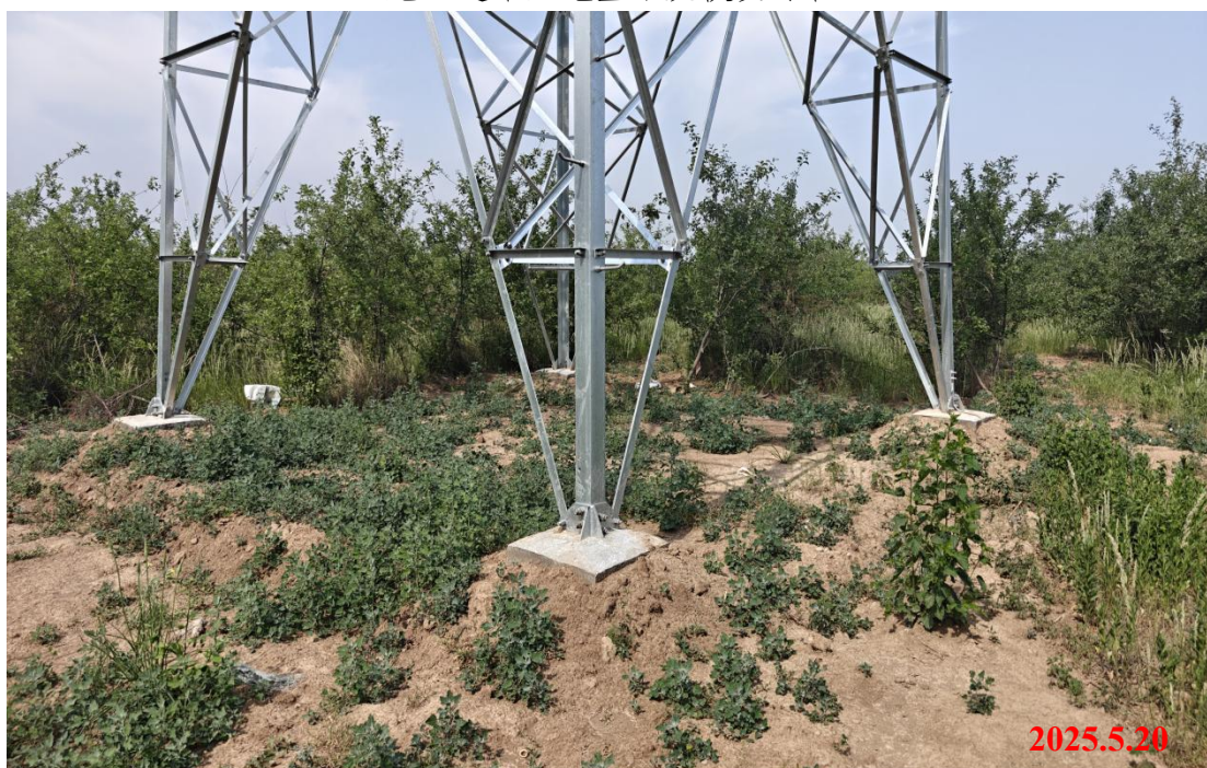
塔基土地整治及恢复绿化
