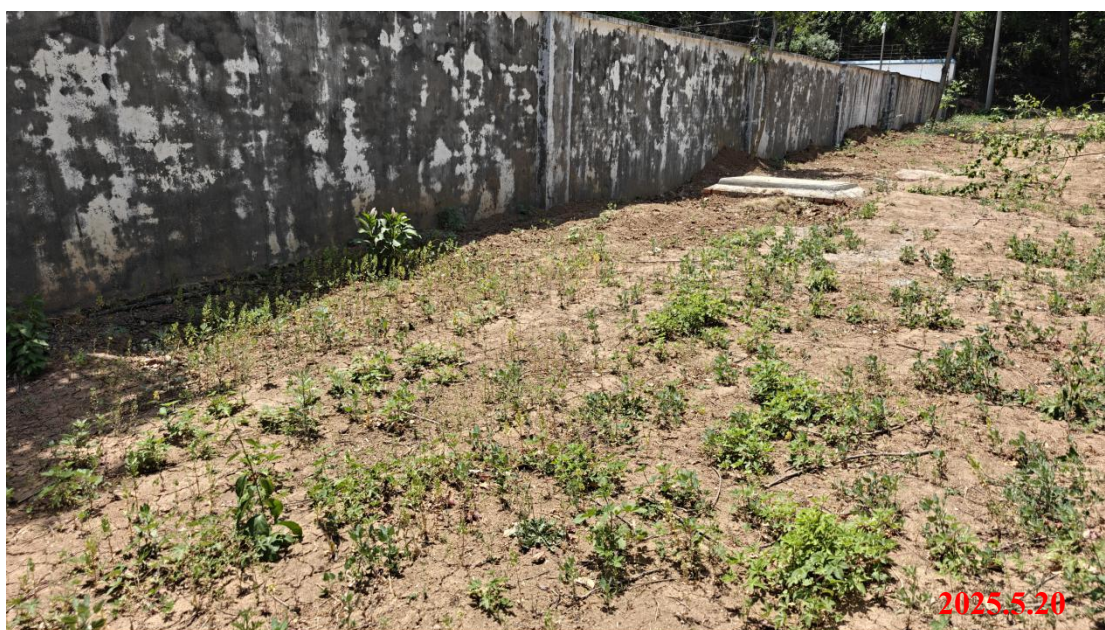
直埋电缆土地整治及恢复绿化
