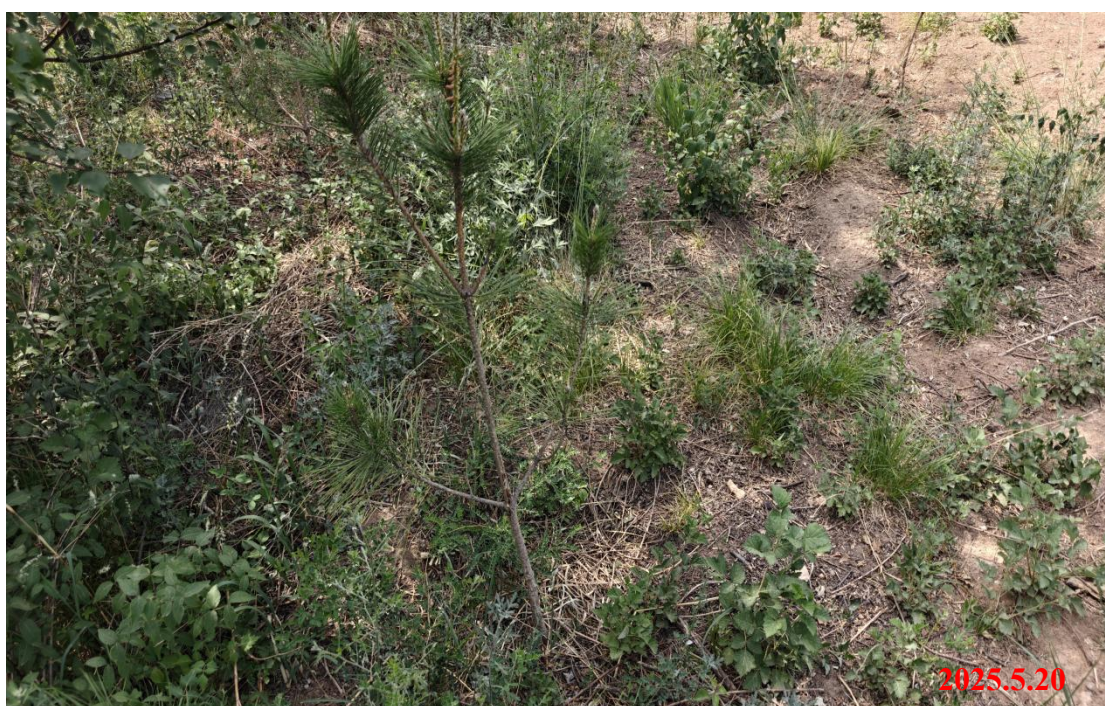
临时施工道路恢复绿化
