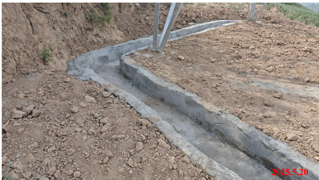
混凝土排水沟
