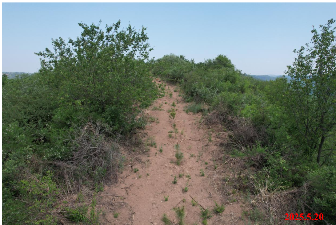
施工道路土地整治及恢复绿化
