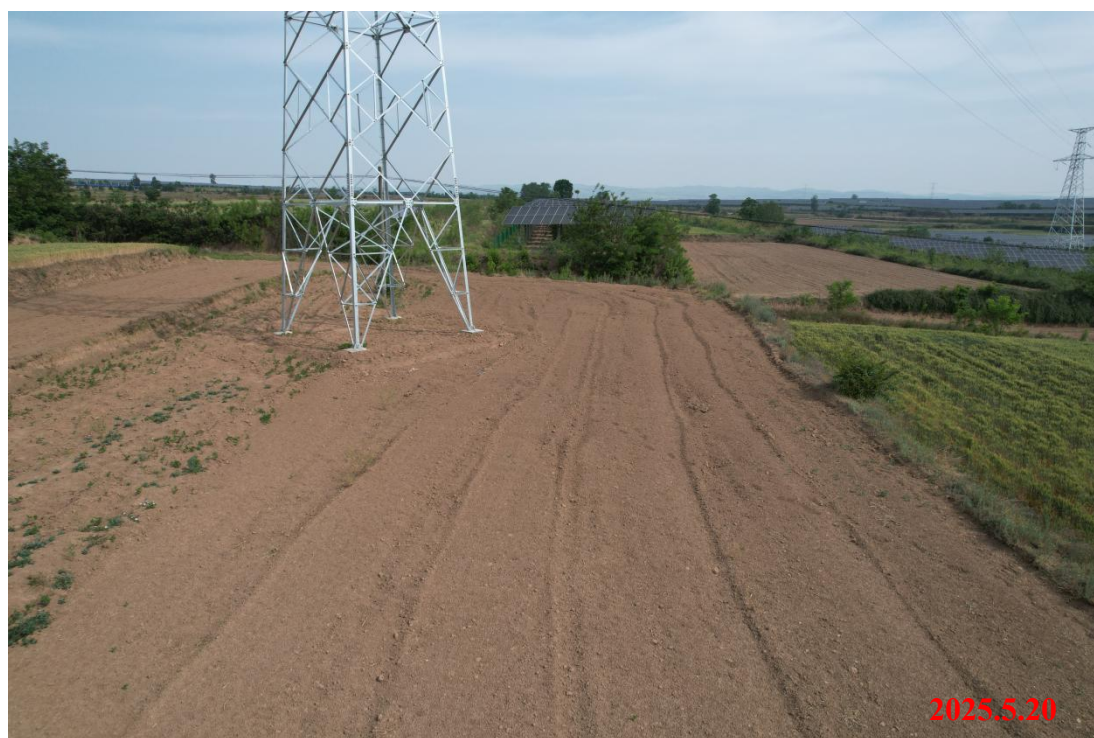
塔基及施工道路土地复耕
