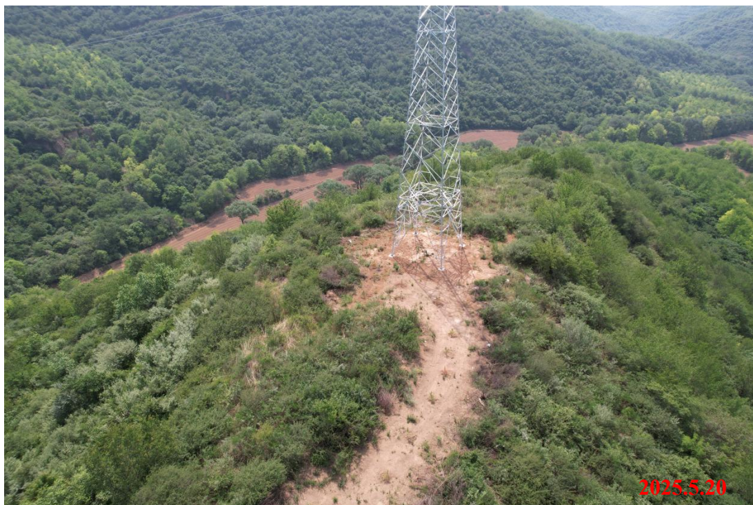
塔基土地整治及恢复绿化
