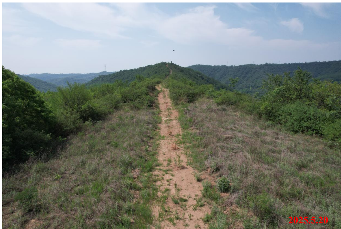
施工道路土地整治及恢复绿化
