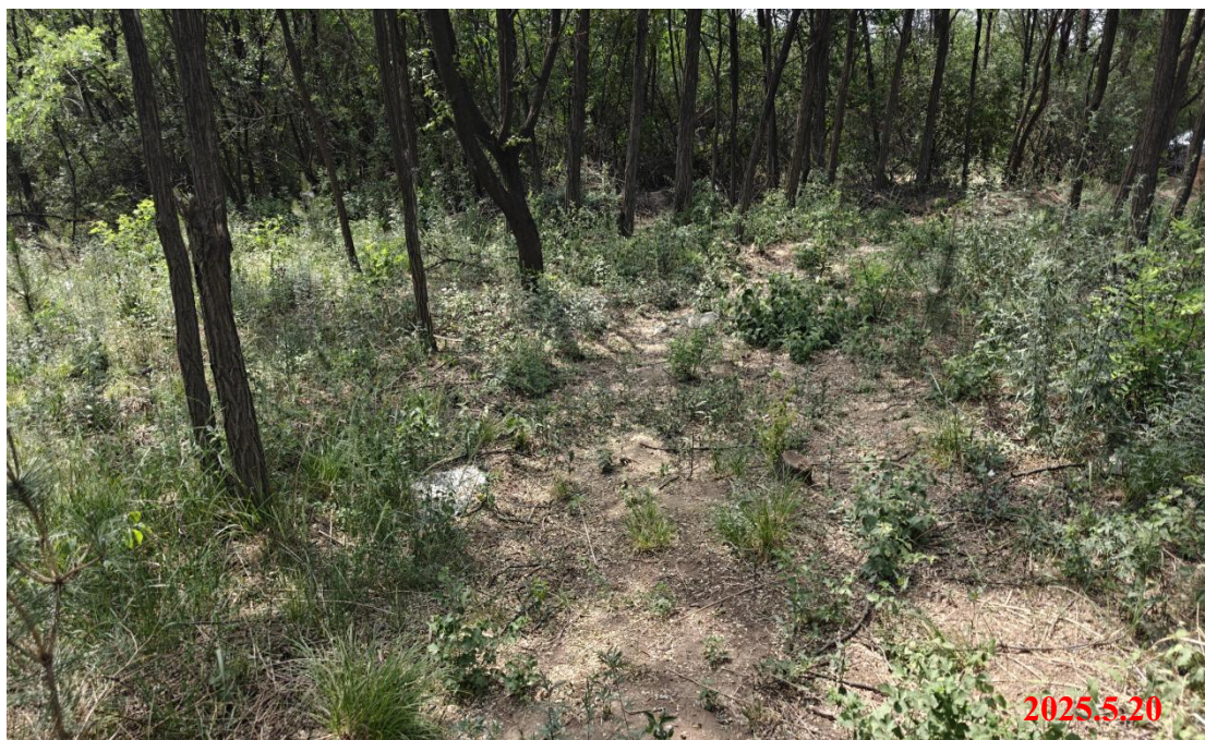
临时施工道路土地整治及恢复绿化
