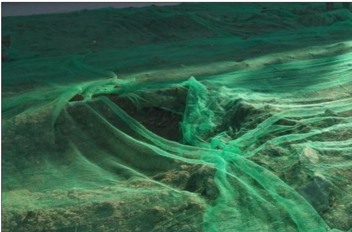
裸露地表苫盖
